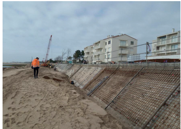
La Faute sur mer (85) - Travaux de restauration de la digue Ouest - Source : Syndicat Mixte Bassin du Lay (SMBL)
